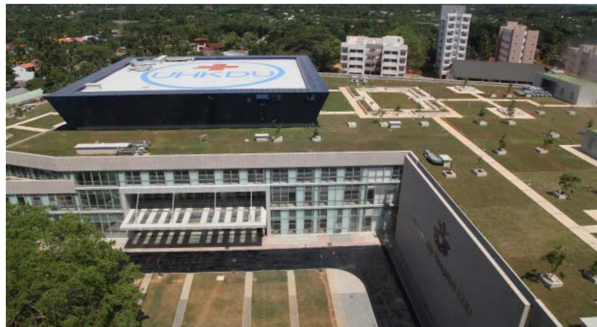
保利国际斯里兰卡国防大学医院项目竣工
