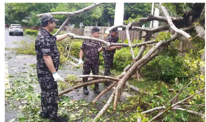
保利发展应急小组人员清理道路障碍，消除安全隐患
