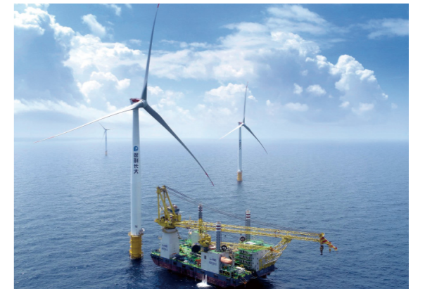
保利长大海上风电项目施工
