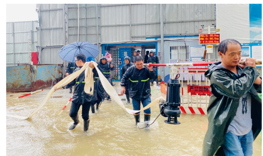
保利物业人员坚守抢险第一线，冒雨疏通园区
